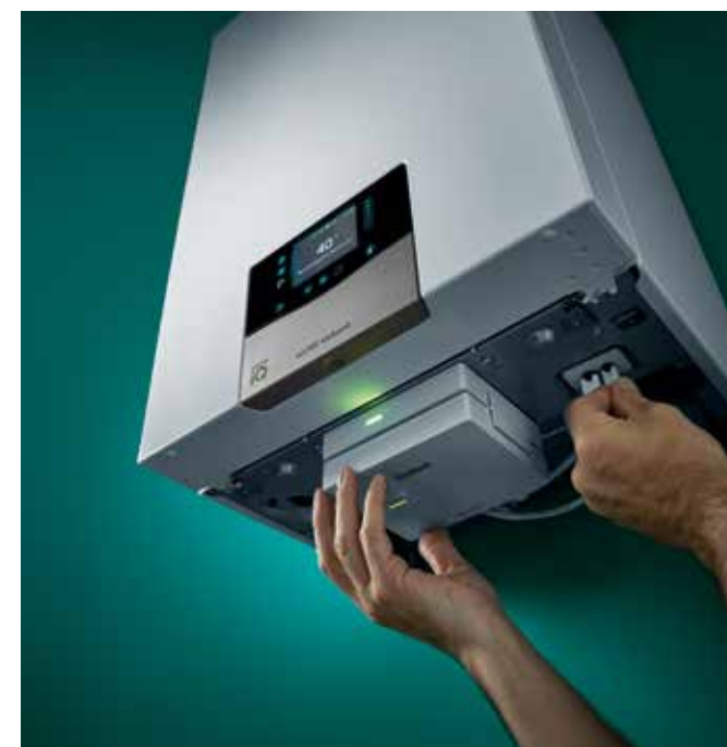
La passerelle internet est inclus en standard et peut être facilement fixé (Plug & Play) sous l'ecoTEC exclusive et l'ecoTEC plus (dernière génération)
