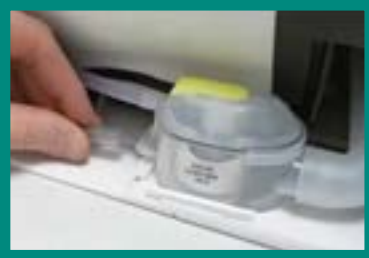
Raccorder le départ des condensats Sluit de condensafvoer aan
