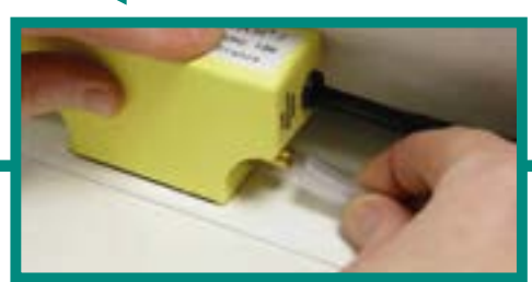
Raccorder le tuyau des condensats à la pompe Sluit de condensleiding aan op de pomp
